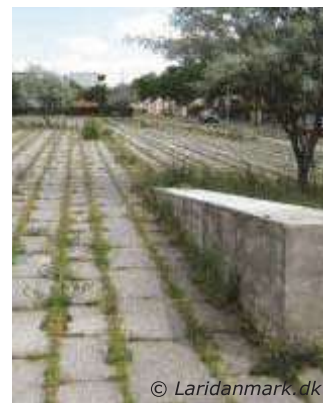
Eksempel belægning med brede fuger
