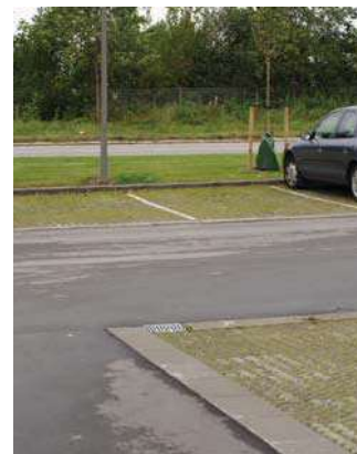
Eksempel belægning med græs- armeringssten
