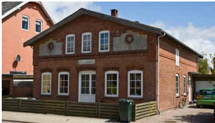
Ballumvej 4 - Gavlhus med lav taghældning og dekorativt murværk, blændinger og bryn over vinduerne.
