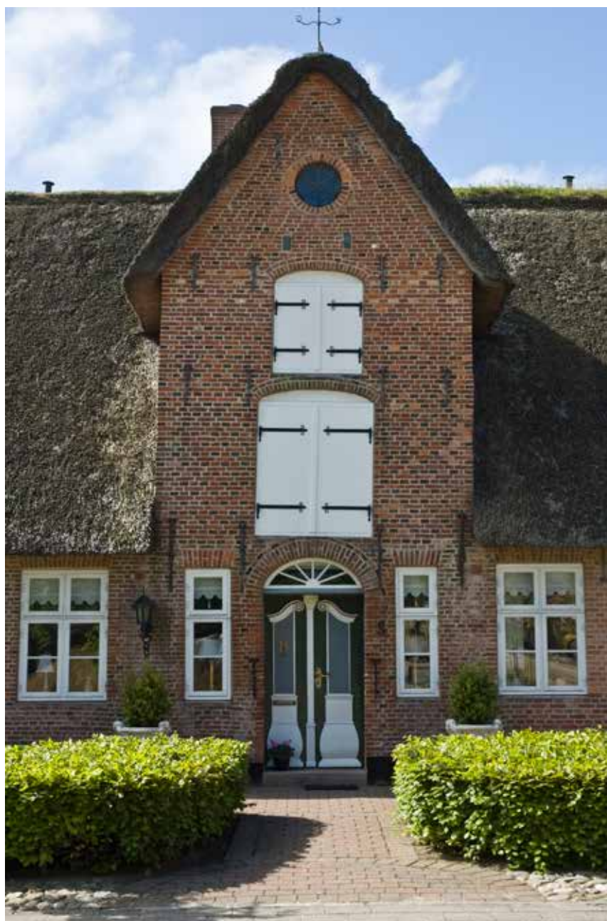
Torvet 3 - Høj frontkvist med luger, murankre og en flot udsåret fyldningsdør.
