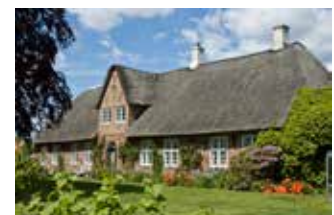
Nørregade 26 - Længehus med stor frontkvist, hvidmalede småsprossede vinduer og flot ubrudt tagflade.
