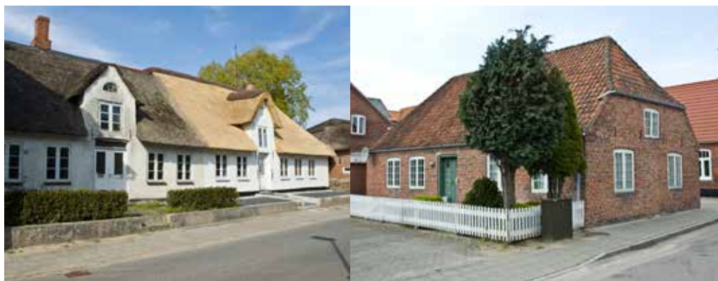
Nyt stråtag i Nørregade samt tegltage i Postgade viser samspillet og bekræfter den gode oplevelse.
