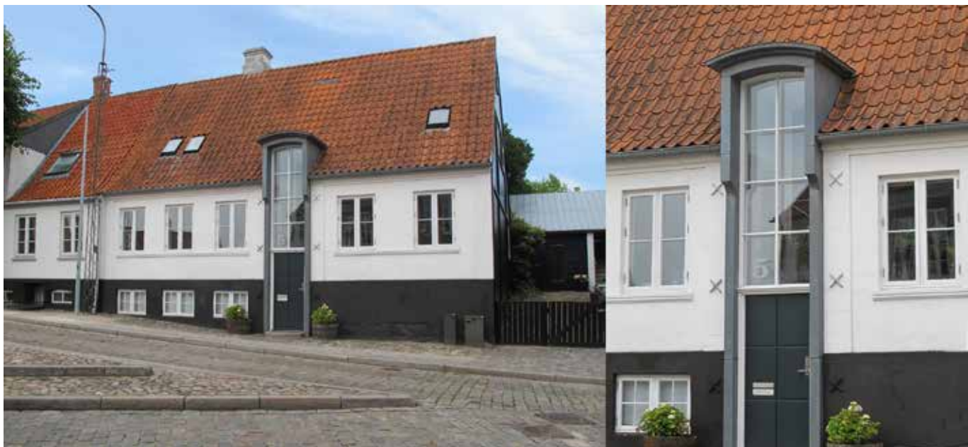
Her er et eksempel fra Haderslev bymidte på moderne bygningsdele og detaljer, der komplementerer og fremhæver bygningens arkitektur jvf. § 6.1.
