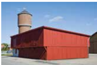
(6) Nørrevej ligner fortsat en indfalds- eller arbejdsvej. Der er mod nord store åbne arealer omkring Brugsen og foderstoffernes haller, vandtårn m.m. Husene overfor mod syd viser en sjælden blanding af gadefacader og lidt rodede gårdsider, der ikke røber, at de har en smuk have og facade side ud mod Nørregade.
