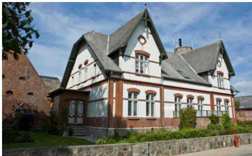
Nørregade 38 - Dobbelt frontkviste med dekorativt spærværk, skifertag.
