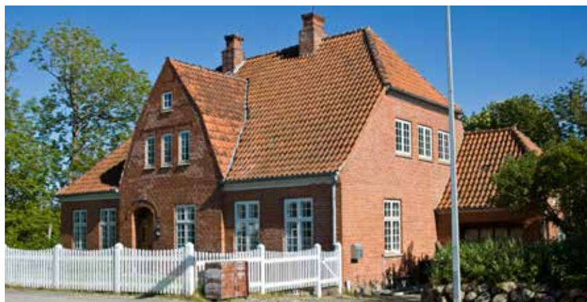
Ved Gamle Dige 1 - Velbevarede småsprossede vinduer, hvidtet gesims og stor gavlkvist med tydelige referencer til marskgårdenes arkengaff.
