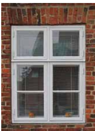
3. de nye vinduer
