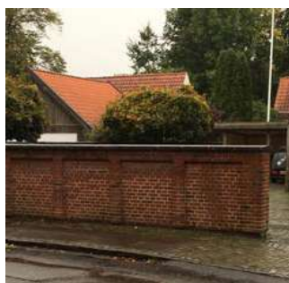
Eksempel på havemur i Nørregade
