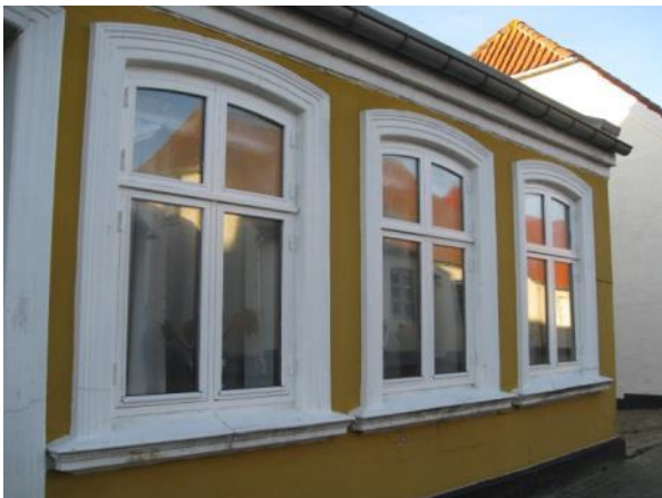
Møllegade 13 a – vinduesindfatninger, sålbænke
