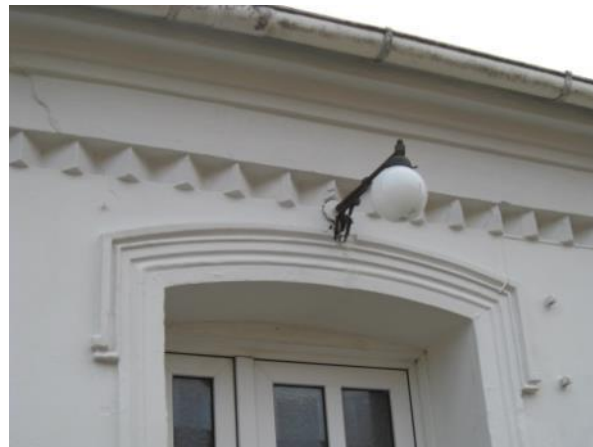
Slotsgade 7 – savtak gesimsbånd, dørindfatning
