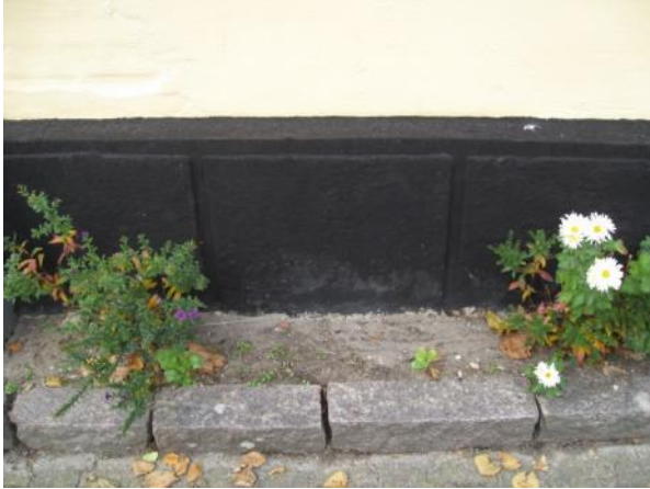
Slotsgade 6 - kvadrepudset sokkel
