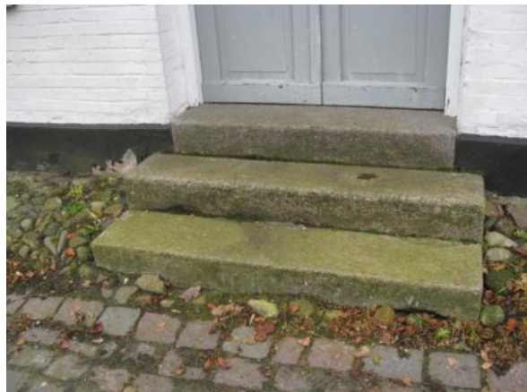
Klostergade 33 – granit trappe, pikstens- og brostens belægning
