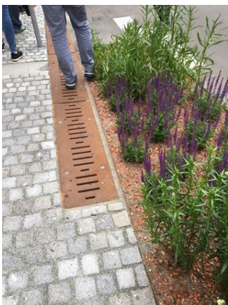
Regnbæd i Middelfart. Her ses beplantet regnbæd i niveau med vej og fortov og rist til afledning af regnvand
